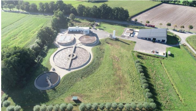
Foto: Klärwerk Steinfeld
